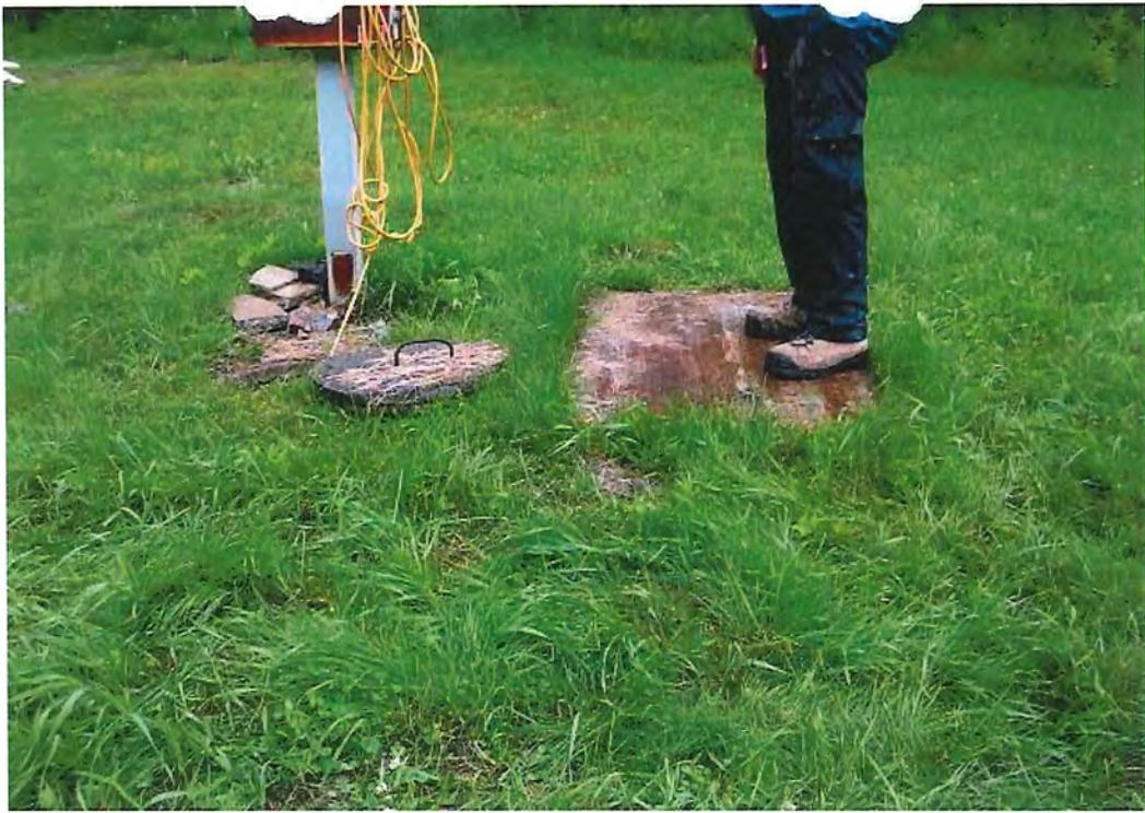
Photo 13 - station de pompage - couvercle endommagé
