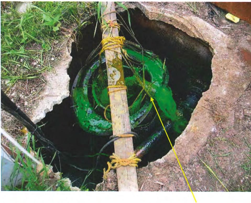
Photo 6 Installation septique 1 – station de pompage – installation artisanale et recirculation
