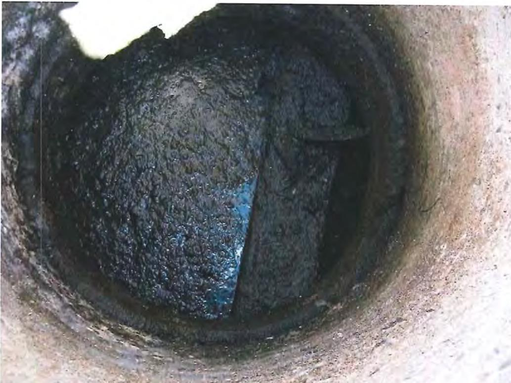
Photo 36 - fosse septique de l'hôtel – présence de boues sur le déflecteur à la sortie deuxième compartiment
