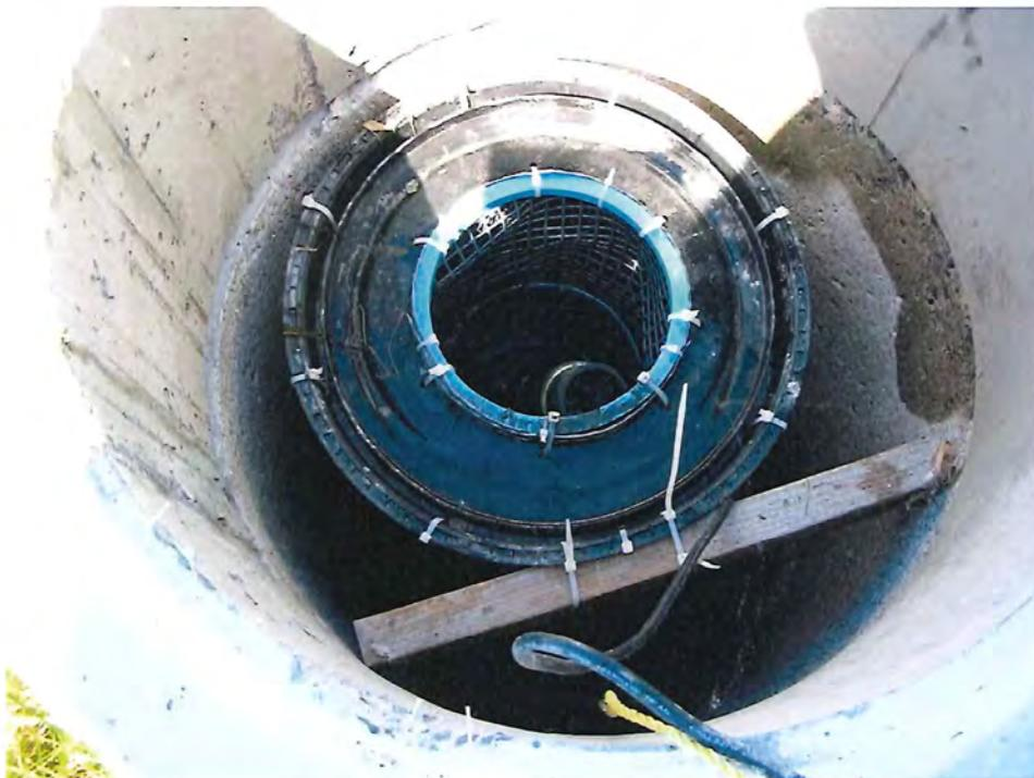
Photo 6 – Installation septique 2 - fosse septique troisième compartiment avec recirculation - DSCN3935.JPG
