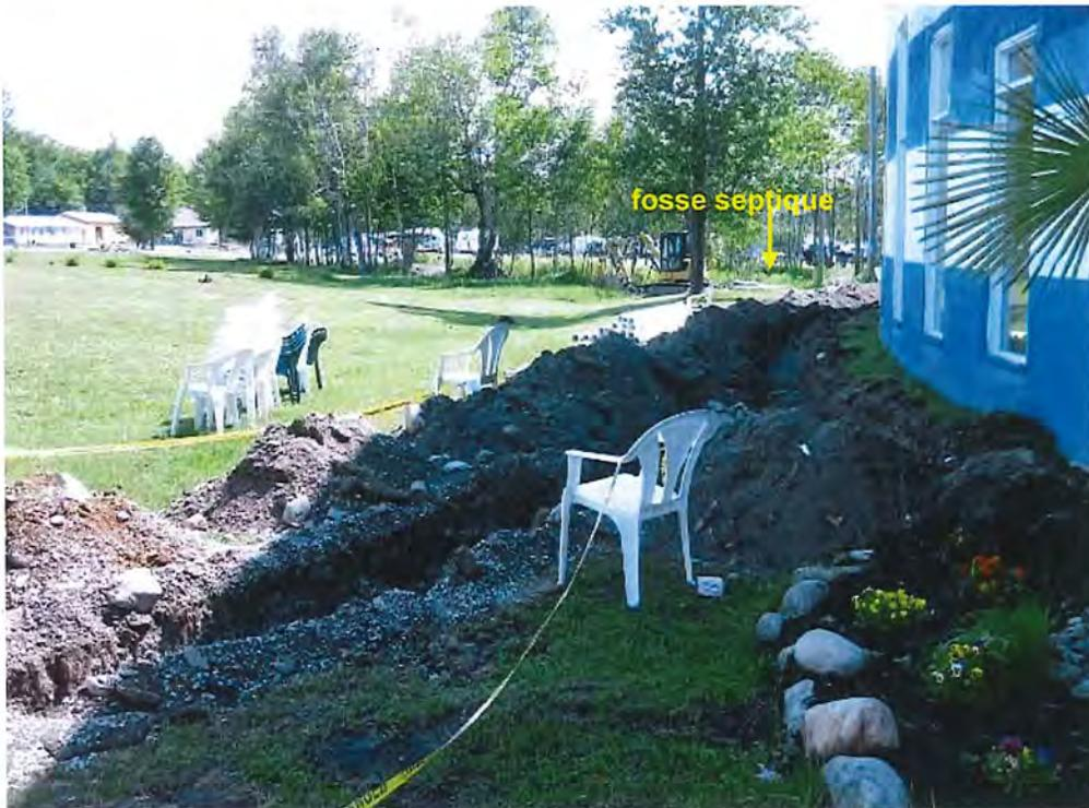
Photo 26 - resto El Alqua Bar - fossé creusé en direction de la fosse septique de la salle communautaire
