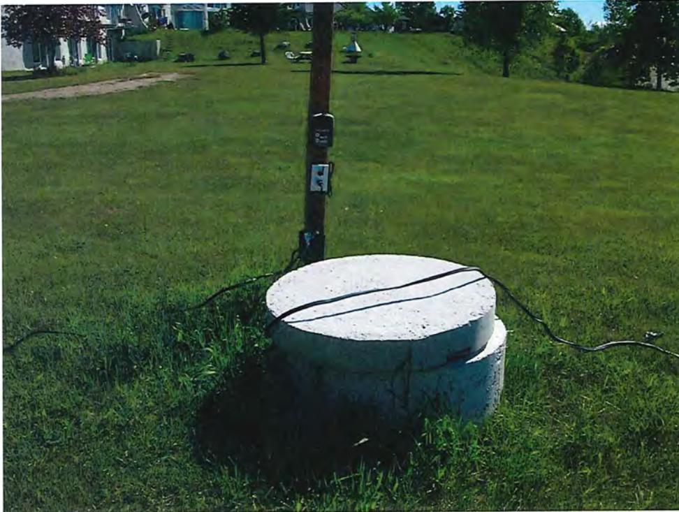
Photo 2 – Installation septique 2 - fosse septique premier compartiment avec alarme - DSCN3929.JPG
