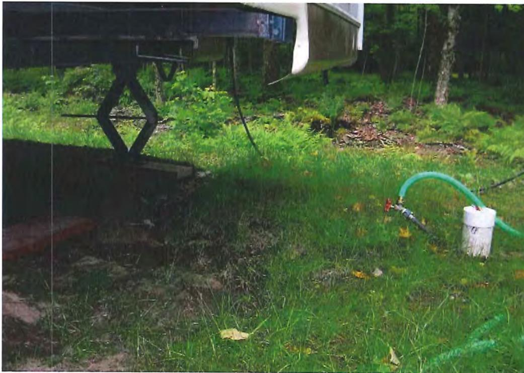
Photo 5 – roulotte non raccordée, eaux grises possiblement rejetées sur le sol
