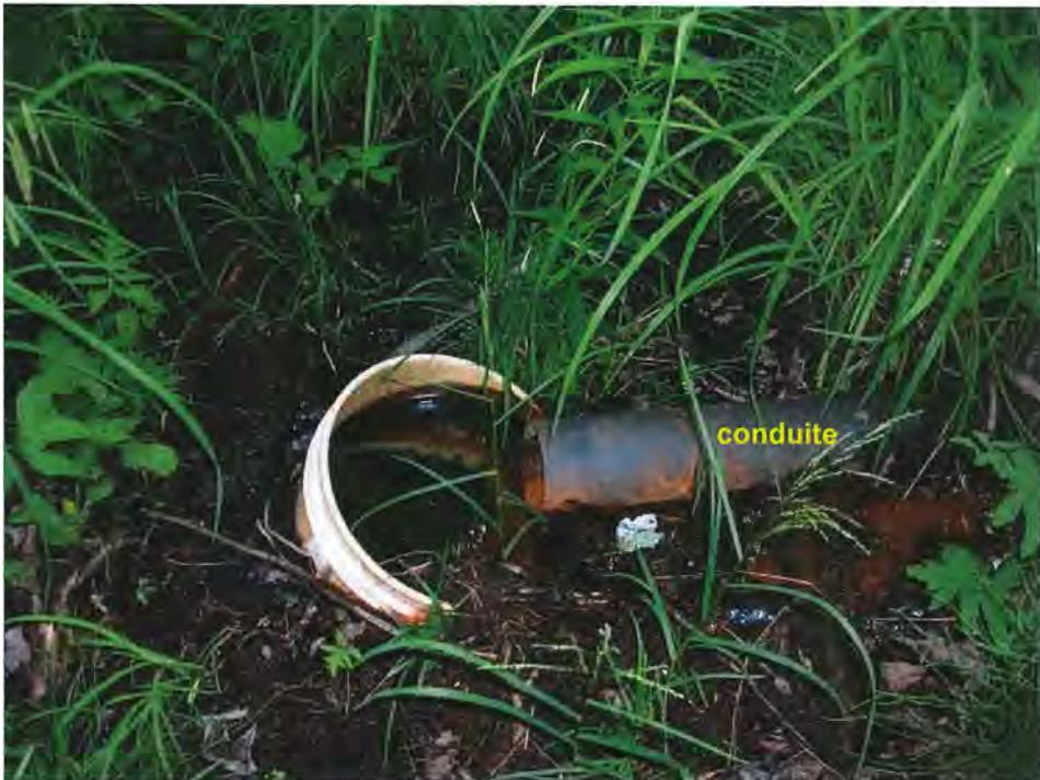
Photo 14 Installation septique 1 – conduite en provenance du centre des champs de l'élément épurateur
