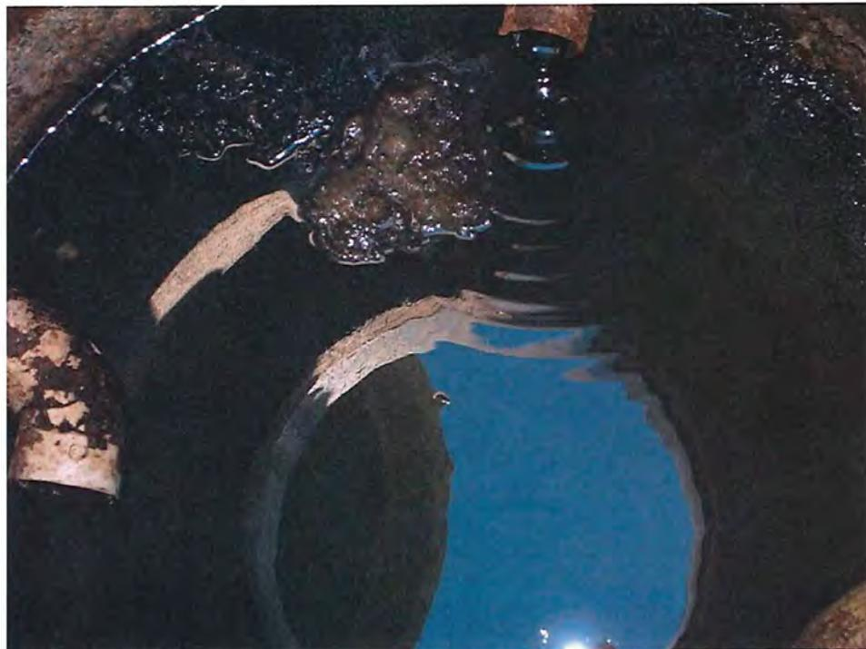
Photo 8 - Installation septique 2 - répartiteur avec présence de boues - DSCN3943.JPG
