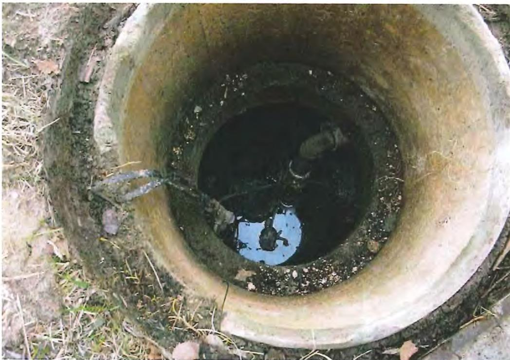
Photo 41 – salle communautaire – deuxième compartiment de la fosse septique muni d'une flotte et d'une pompe
