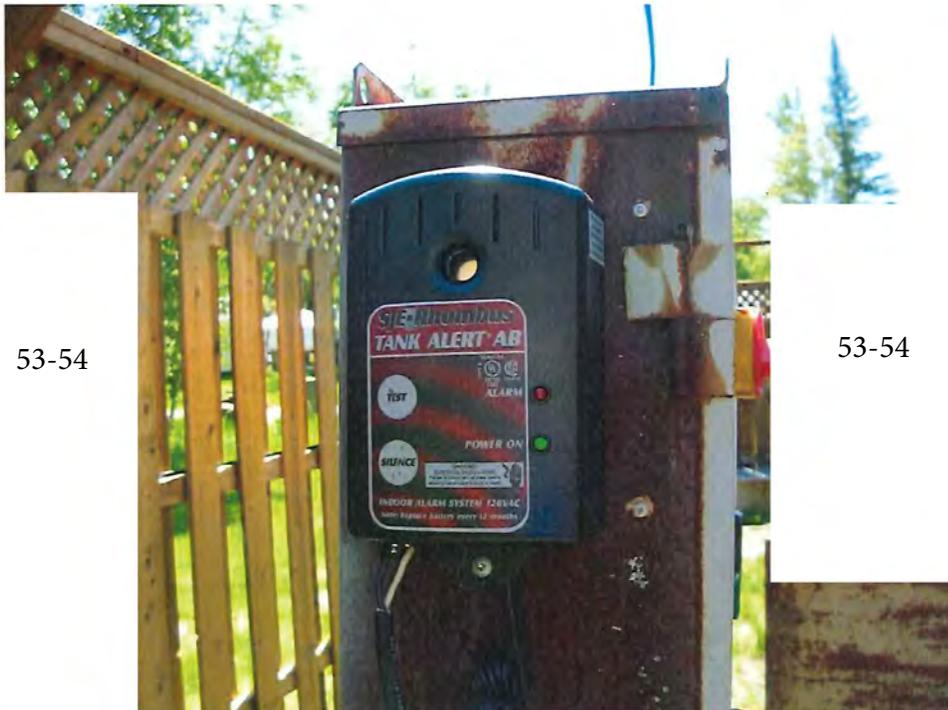
Photo 17 - Installation septique 1 - alarme de la station de pompage - DSCN3972.JPG
