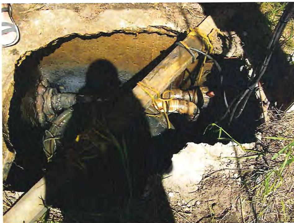
Photo 24 - Installation septique 1 - station de pompage – ouverture béante - *DSCN3963.JPG*
