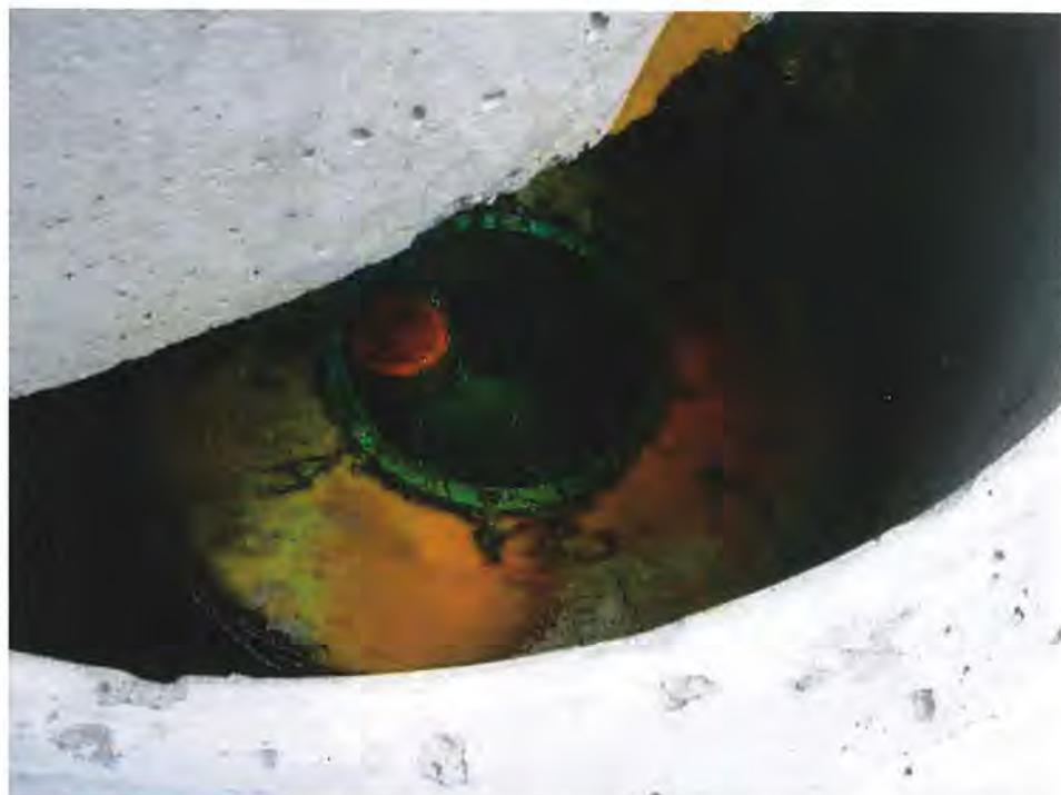
Photo 27 Installation septique 2 – premier compartiment de la fosse septique muni d'un système artisanal
