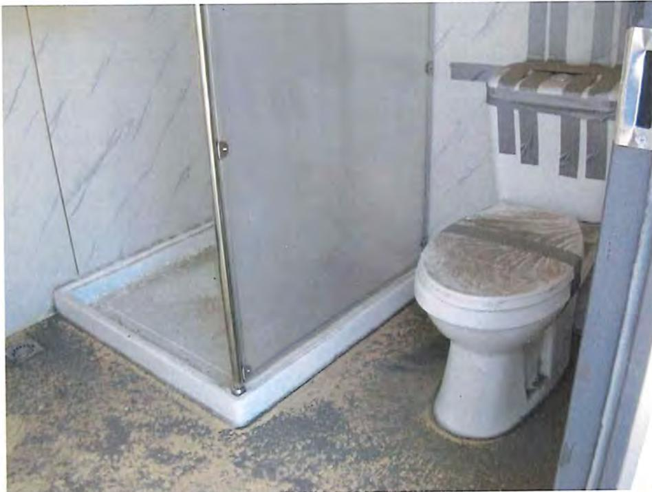
Photo 41 - blocs sanitaires portatifs avec douche et cabinet d'aisance- DSCN4002.JPG
