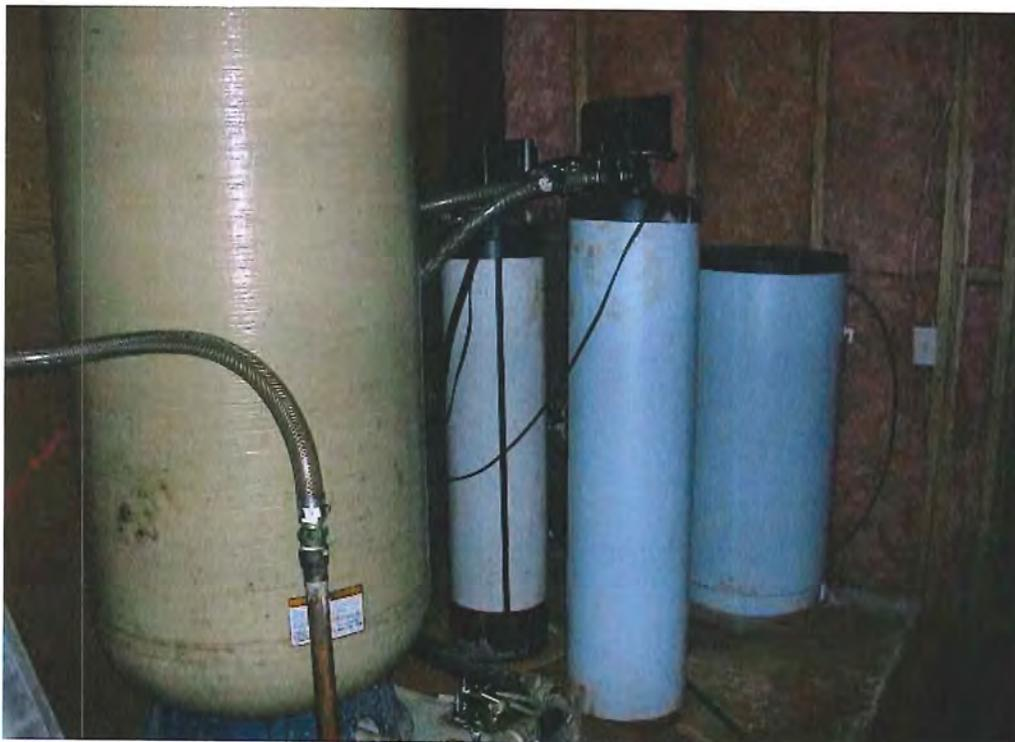
Photo 12 – sous-sol de l'hôtel - adoucisseur et réservoir à pression
