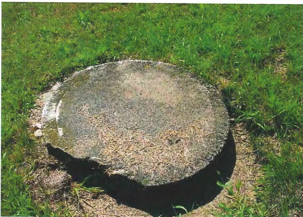
Photo 42 - chambre de répartition - gazon séché autour du couvercle endommagé
