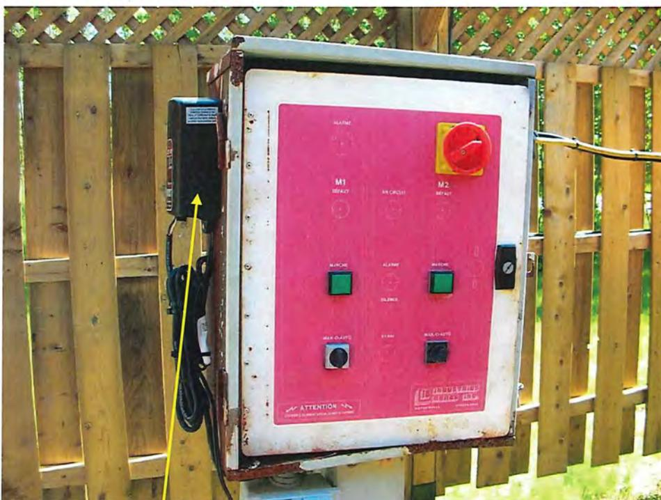
Photo 26 - Installation septique 1 – panneau de contrôle avec nouvelle alarme - DSCN3971.JPG
