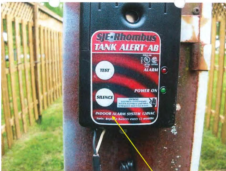
Photo 7 Installation septique 1 – station de pompage – nouvelle alarme d'intérieur
