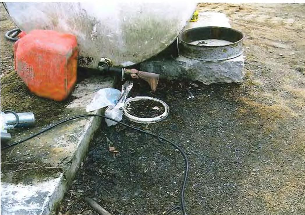
Photo 45 - présence de sols contaminés par de l'huile à chauffage derrière le motel
