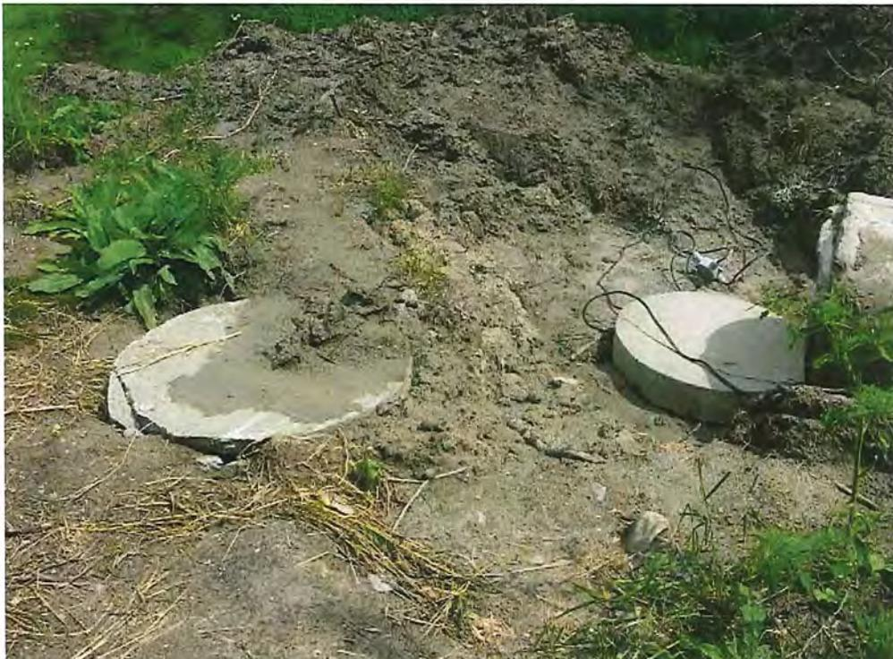
Photo 27 — fosse septique de la salle communautaire - couvercles se trouvant environ 30 centimètres sous la surface du sol
