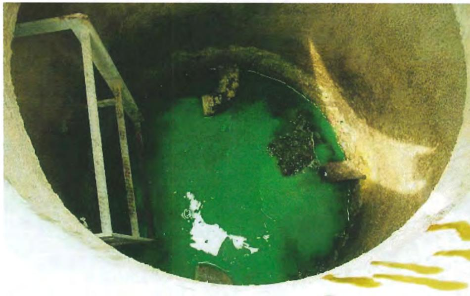
Photo 30 Installation septique 2 – répartiteur - présence de boues à la surface du liquide
