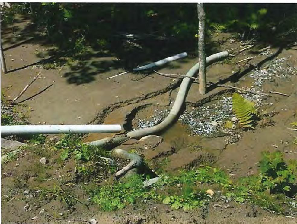
Photo 21 – quatre conduites acheminant les eaux dans le bois derrière la piscine
