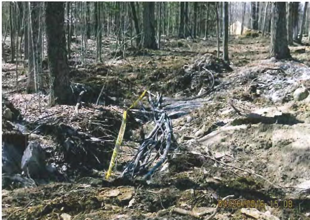
Photo 28 - sites 513 à 529 – filage électrique et conduites d'eau potable enchevêtrées
