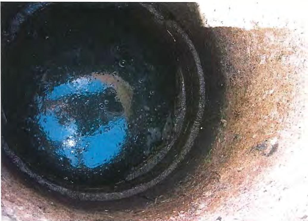
Photo 39 - poste de pompage - rempli d'eau et traces dans la cheminée d'accès
