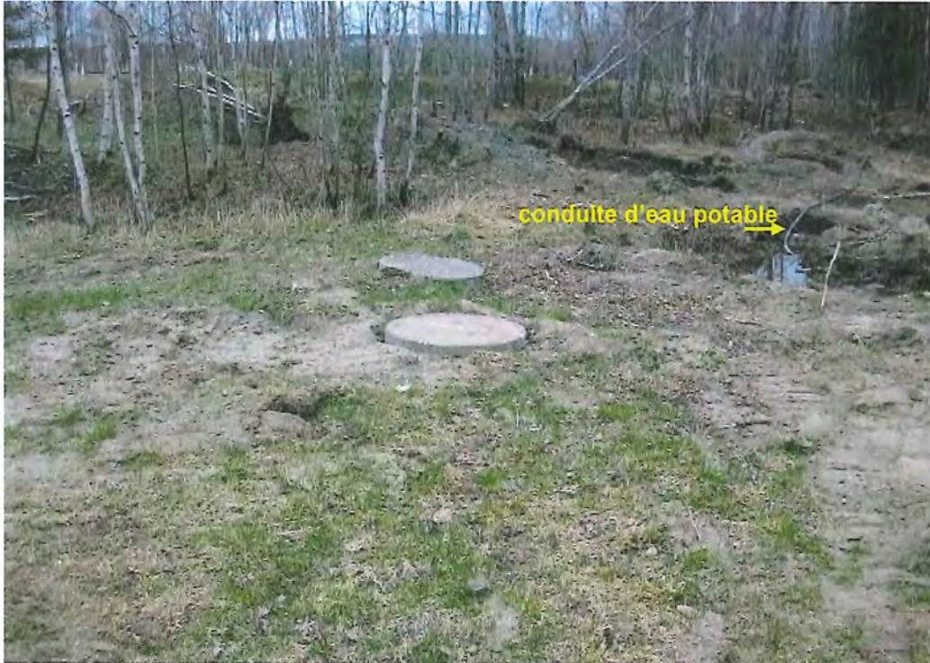
Photo 40 - salle communautaire – couvercles de la fosse septiques se trouvant à la surface du sol
