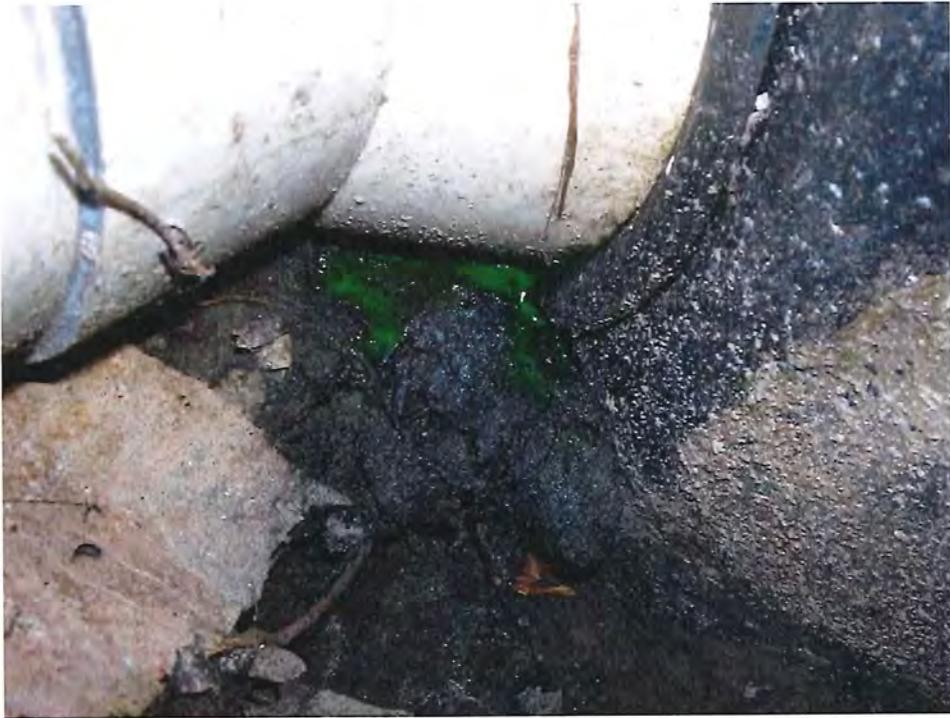
Photo 34 - Station de pompage A1 – écoulement de fluorescéine au joint de la conduite- *DSCN3996.JPG*
