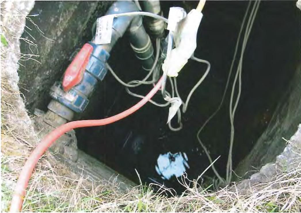
Photo 34 - station de pompage munie de deux pompes
