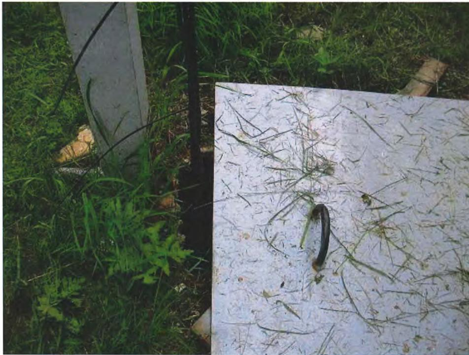
Photo 5 Installation septique 1 – station de pompage – couvercle non étanche
