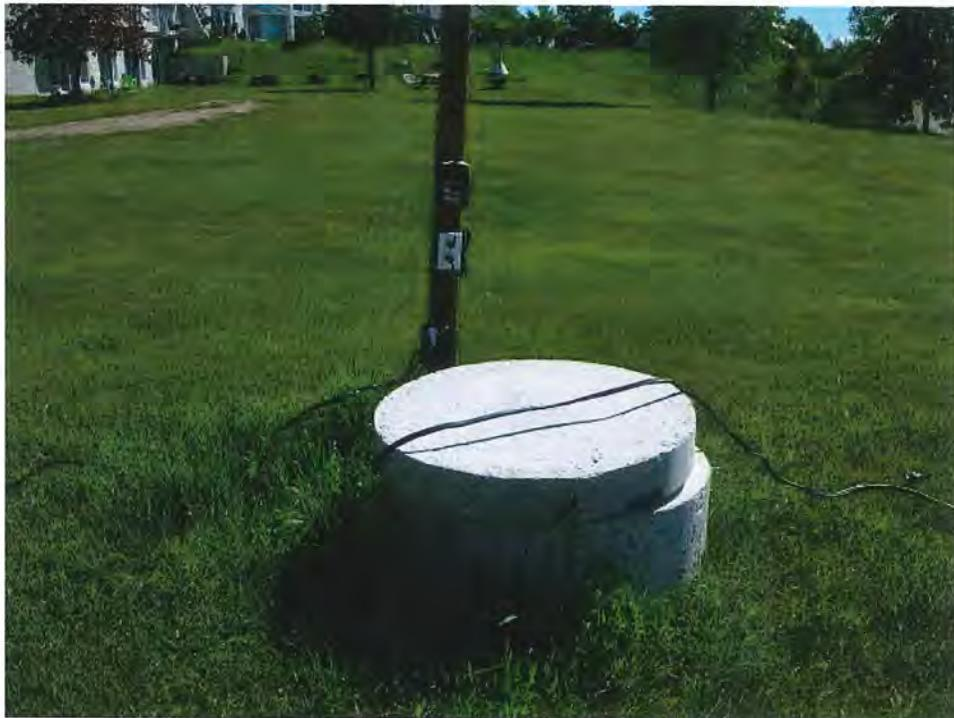
Photo 26 Installation septique 2 – premier compartiment de la fosse septique avec alarme
