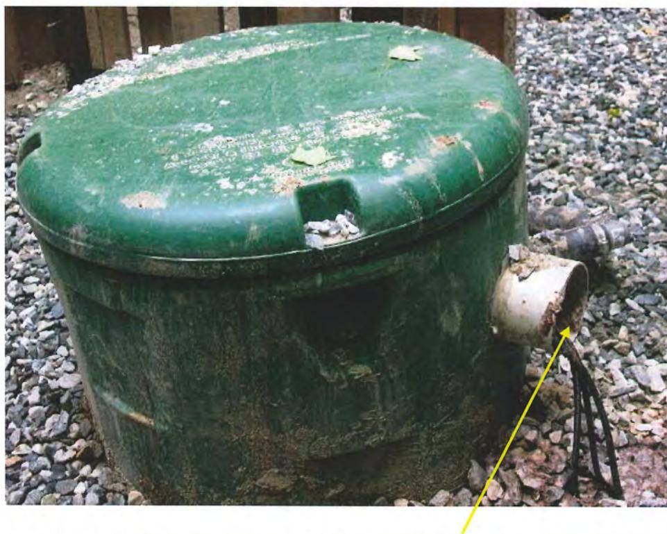
Photo 18 Station de pompage 1A située au sud du site 517 – traces de boues dans la conduite de trop plein
