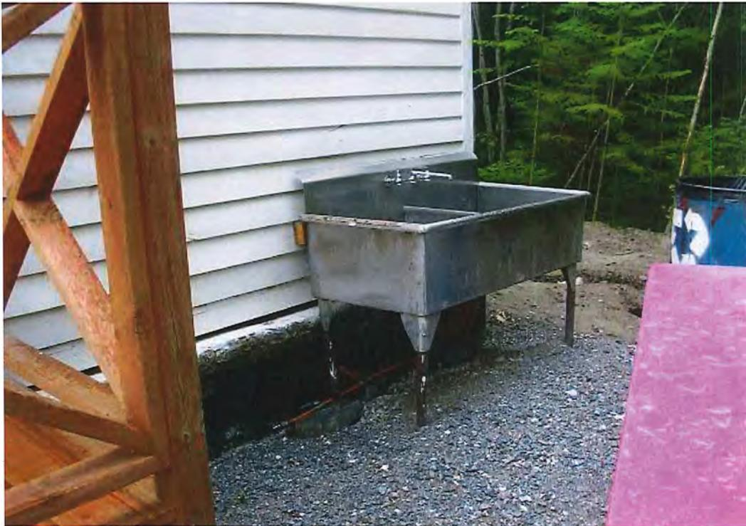
Photo 8 - resto El Rancho - lavabo extérieur alimenté par des conduites d'eau potable
