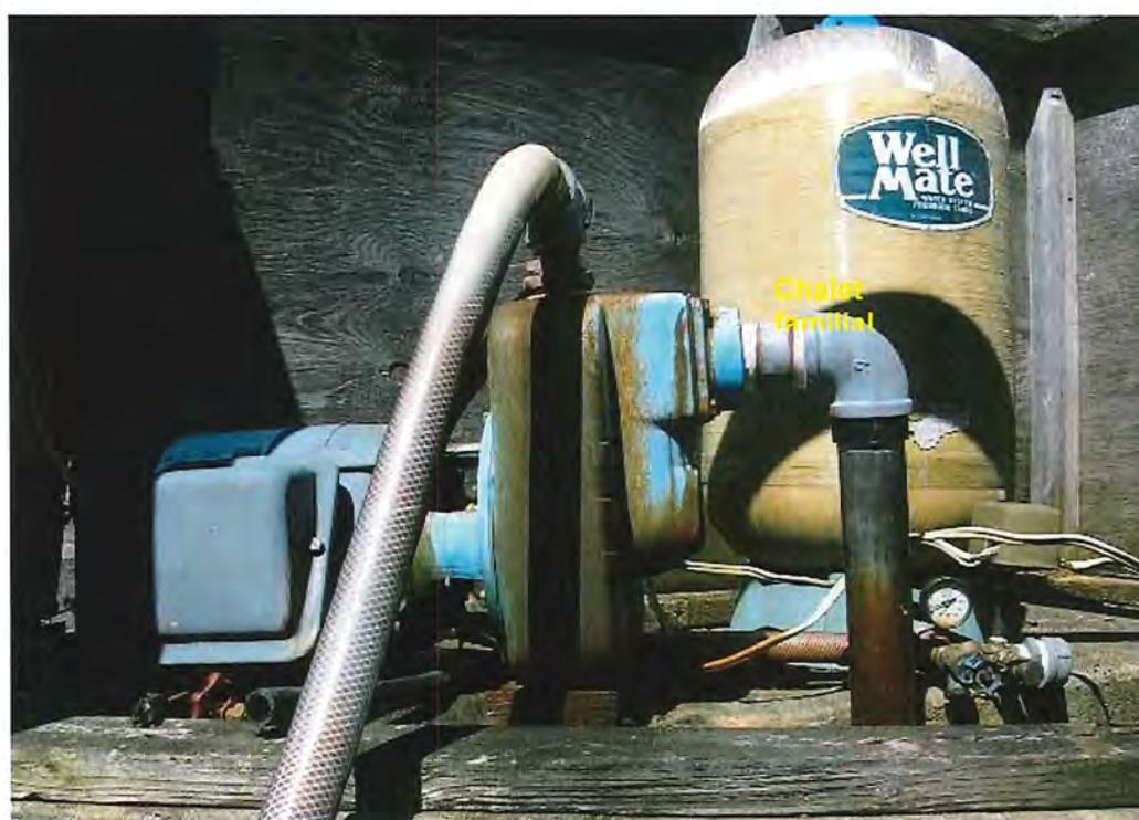
Photo 20 - ancienne réserve d'eau potable –réservoir à pression
