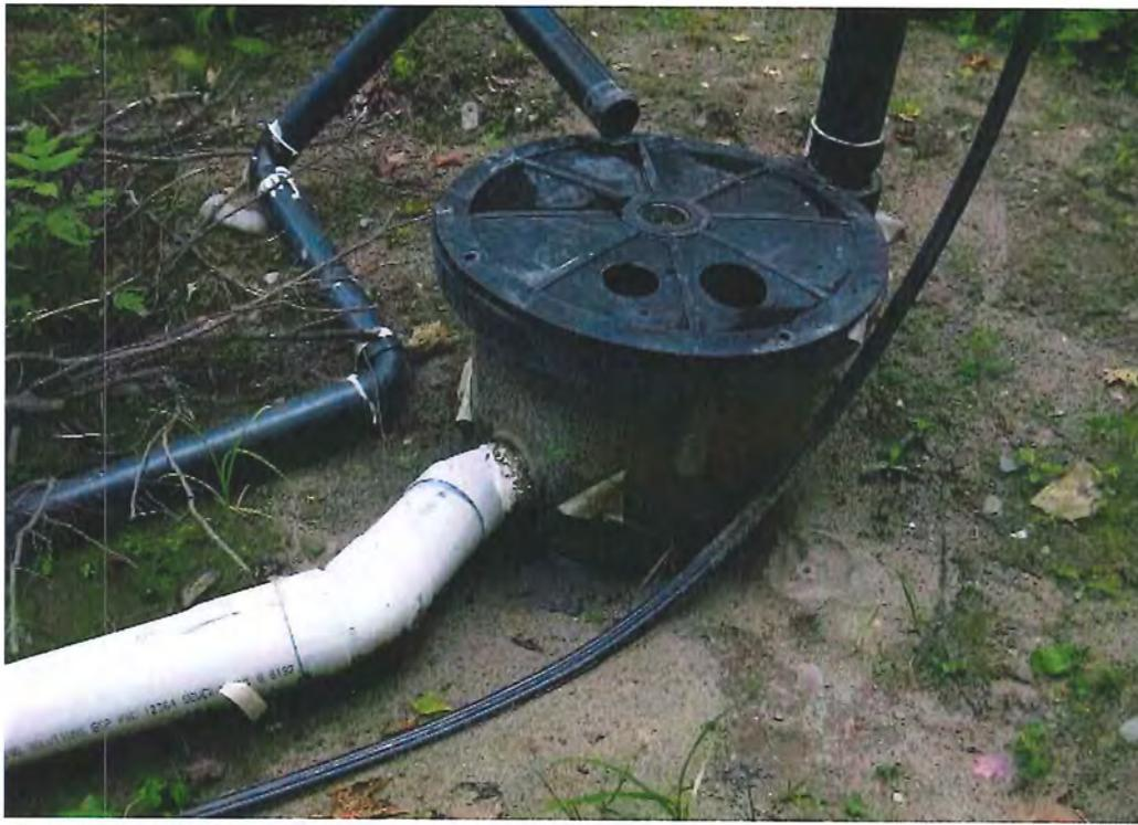
Photo 4 - mini station de pompage – conduite de refoulement débranchée
