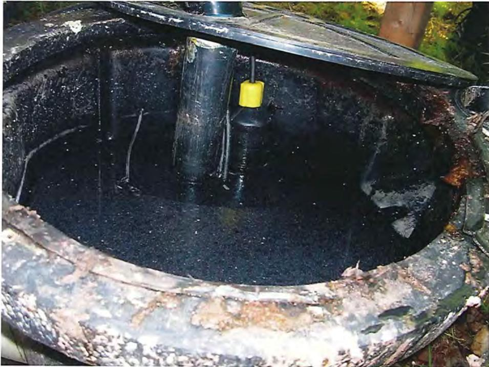
Photo 32 - Station de pompage A1 - traces de débordement sur le pourtour du couvercle et à l'extérieur -DSCN3988.JPG
