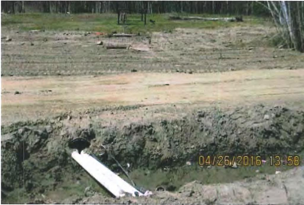
Photo 16 - conduites d'eau potable et d'eaux usées ensemble dans un petit ponceau
